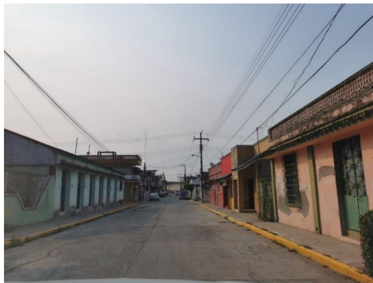
Figura 76. Tipología de vivienda.
